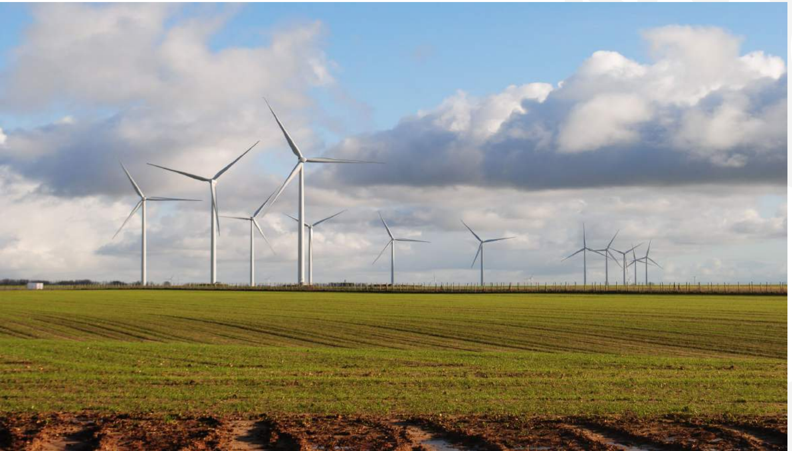
Les 12 éoliennes de Buire-le-Sec.
